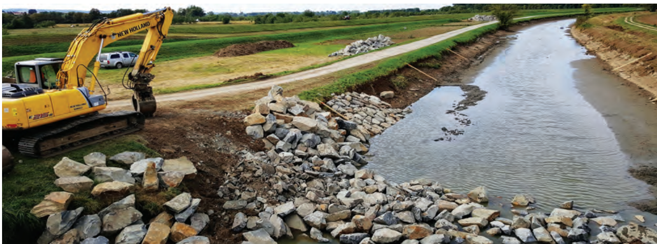
Opravy opevnění Baťova kanálu
