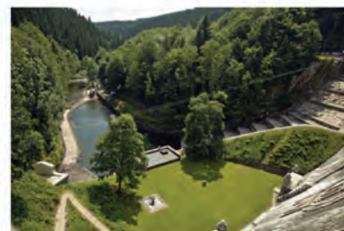
Probíhající rekonstrukce Labské přehrady, Spindlerův Mlýn
