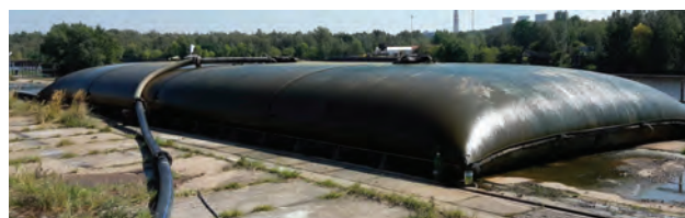
Speciální vak pro odfiltrování vody z bahna
