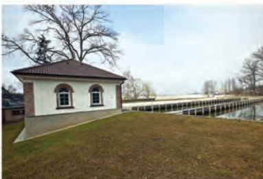
Doplnění technologie v úpravě vody, Plzeň
