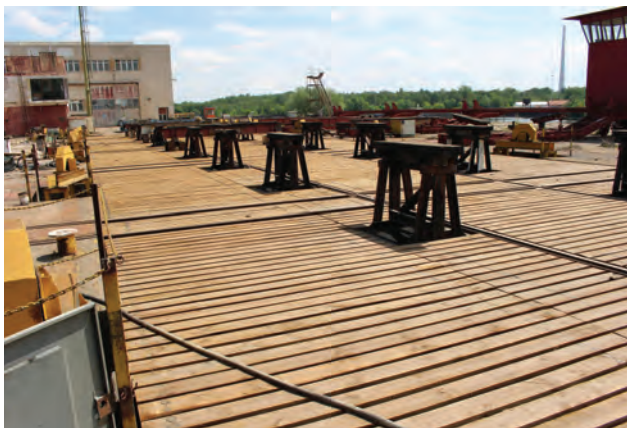
Zrekonstruovaný pojezd pro lodě do haly
