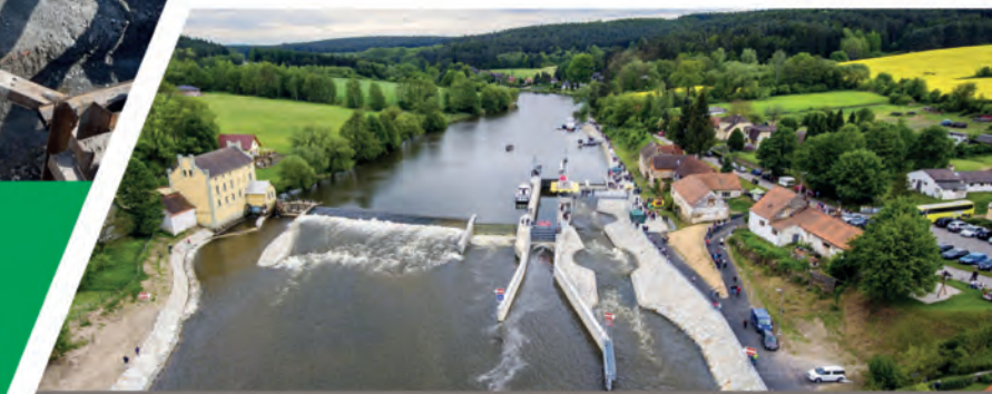
Nová plavební komora u jezu Hněvkovice na Vltavě
