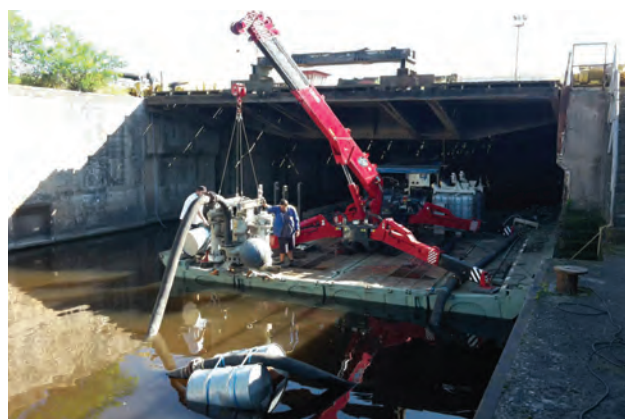
Odbahnění lodního zdvihadla sacím bagrem
