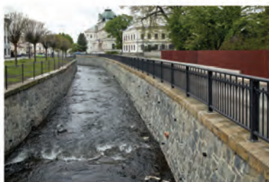
Odstranění povodňových škod, Česká Kamenice
