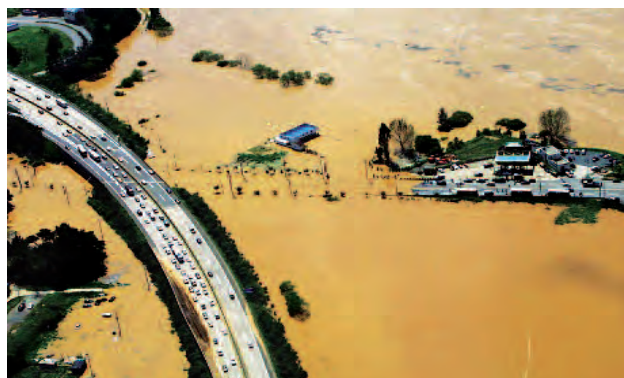
Řeka Nakdong často trpí povodňovými škodami v důsledku silných letních dešťů. Tajfun Maemi zcela zaplavil město Daejeong v září 2003
