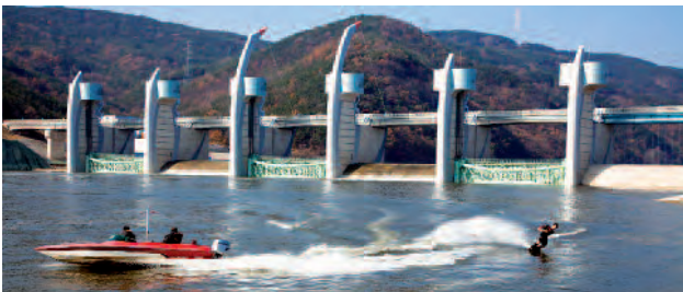
Dokončení projektu umožnilo rozvoj vodních sportů na čtyřech řekách. Na obr. jez Hapcheon Changnyeong na řece Nakdong
