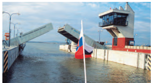
Zdvhací most cez plavebnú komoru Čuňovo
