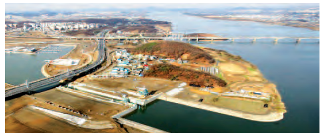
Plavební komora u řeky Han
