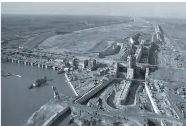
Výstavba elektrárne a plavebných komôr na VD Gabčíkovo
