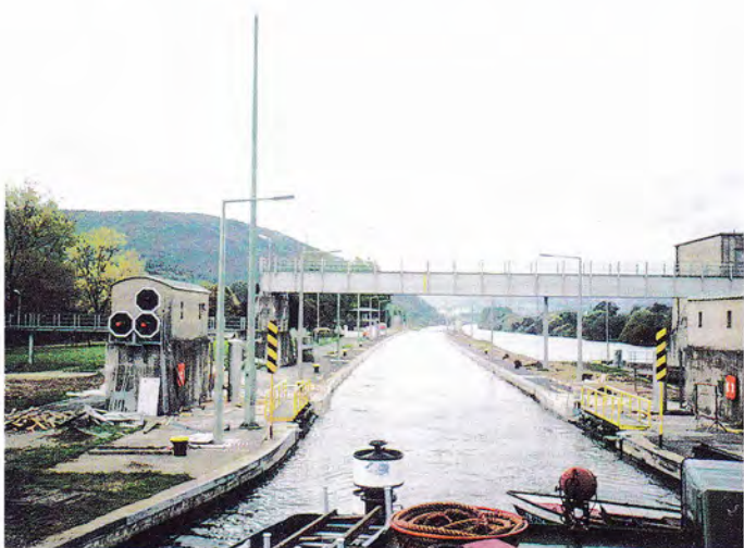
Plavební komora Rothenfels, ř.km 185,5
