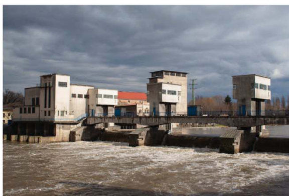
5 Zdymadlo a vodní elektrárna Brandýs nad Labem, 1931–1935, Kamil Roškot, Kapsa & Müller
