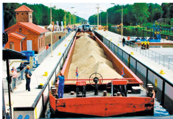
Slavnostní uvedení do provozu rekonstruované a prodloužené plavební komory Kersdorf na kanálu Odra-Spréva (9,8x115 m). Za Unii hospodářských komor Odra Labe se aktu zúčastnil Ing. Jiří Aster
