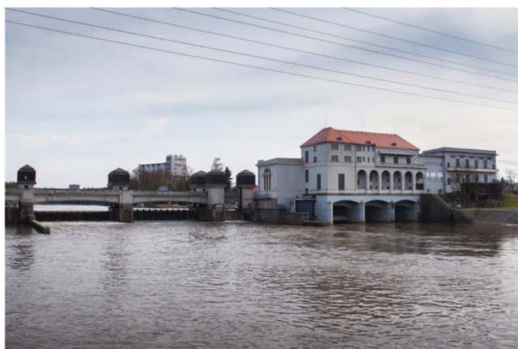
6 Zdymadlo a vodní elektrárna Přelouč, 1920–1928, A. Engel
