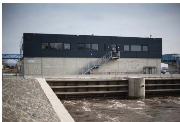
13 Malá vodní elektrárna Štětí, 2015
