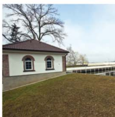
Doplnění technologie v úpravě vody, Plav
