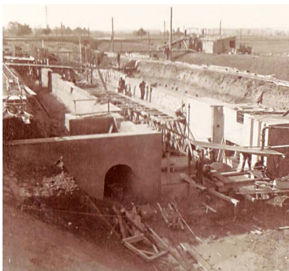
Výstavba plavební komory na Baťově kanálu ve 30. letech
