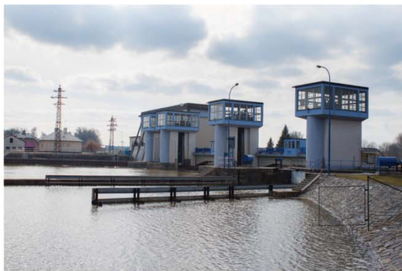
7 Zdymadlo a vodní elektrárna Srnojedy, 1937–1947
