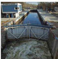
Modernizace pletební komory, Brandýs nad Labem
