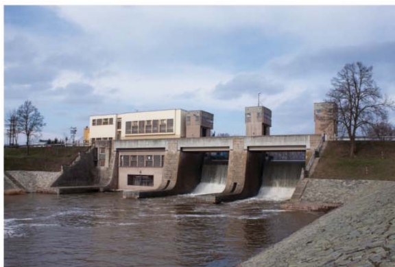
4 Jez a vodní elektrárna Předměřice, 1942–1947, arch. Josef Štěpánek
