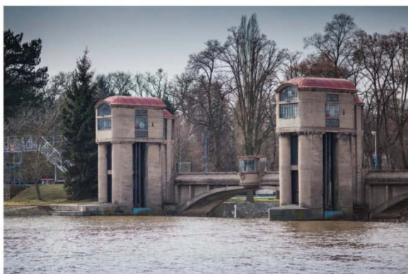
2 Zdymadlo a vodní elektrárna Nymburk, 1914–1924 František Roith
