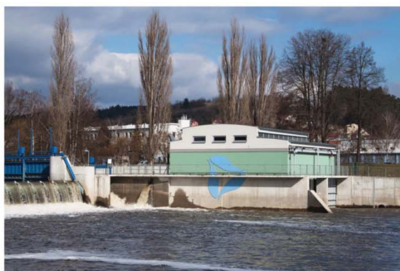
14 Malá vodní elektrárna Beroun, 2011
