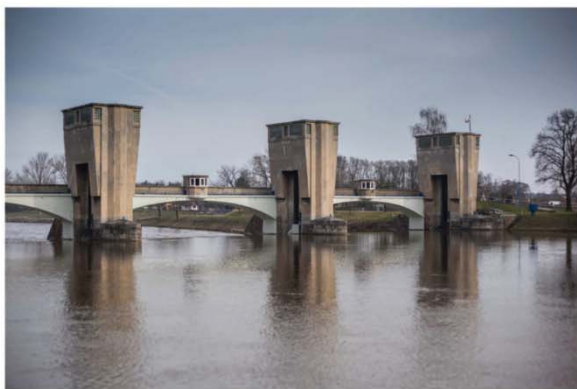
1 Zdymadlo a vodní elektrárna Lobkovice, 1914–1927, František Roith, Nejedlý a Řehák
