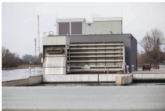
12 Vodní elektrárna Liběchov, 2015
