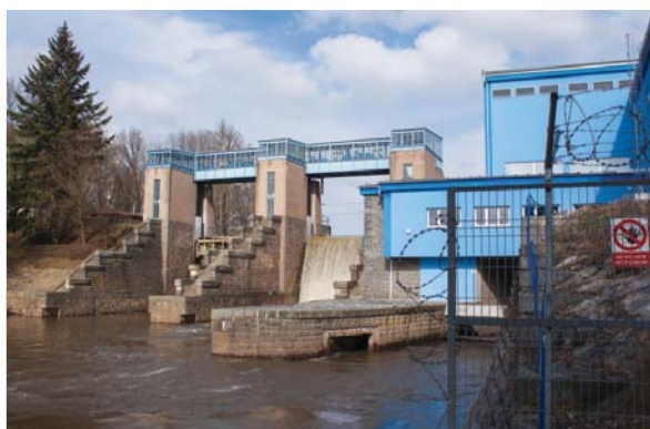
8 Jez a vodní elektrárna Smičice, 1937–1952, František Bartoš
