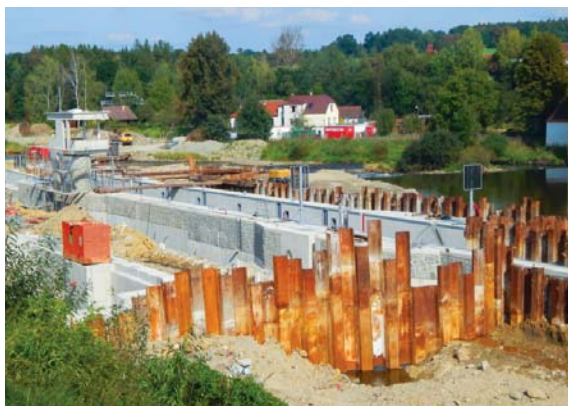
Výstavba plavební komory na jezu Hněvkovice v září 2016. Foto: Jan Šindelář
