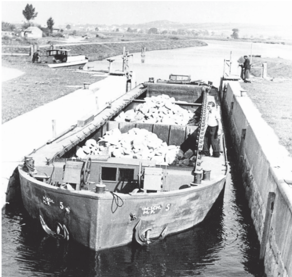
Loď s nákladem kameniva na původním Baťově kanálu
