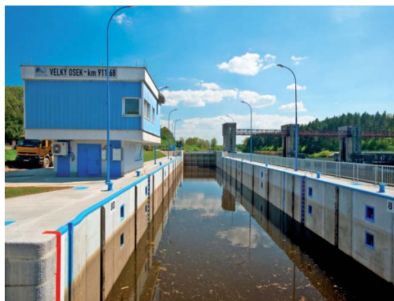
Plavební komora Velký Osek po modernizaci
