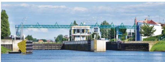
Plavební komory České Kopisty
