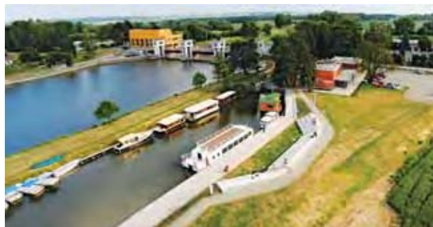
V loňském roce dokončilo Ředitelství vodních cest ČR nové přístaviště na Baťově kanálu ve Splytihněvi
