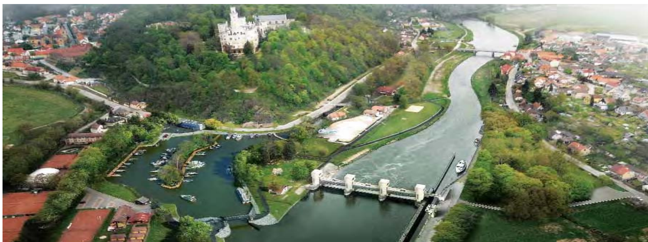
Splavnění Vltavy prokázalo své přínosy v protipovodňové ochraně při letošních červnových povodních. Na obrázku dokončená plavební komora v Hluboké nad Vltavou a budoucí podoba budovaného přístavu
